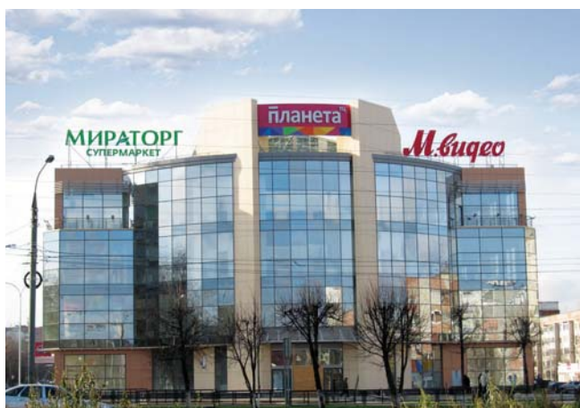
ТОРГОВЫЙ ЦЕНТР «ПЛАНЕТА» Йошкар-Ола, 836 квТ
