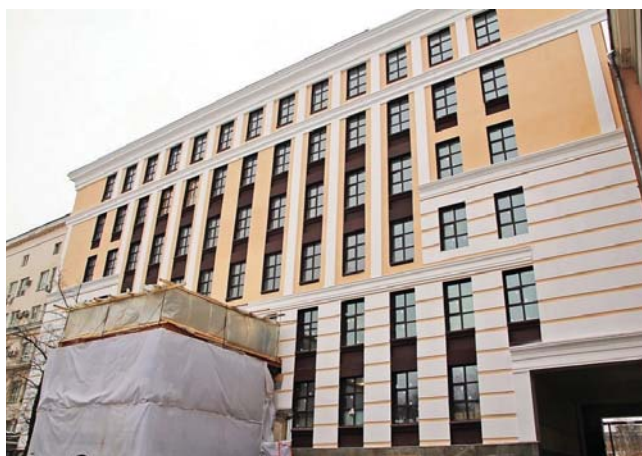
БИЗНЕС-ЦЕНТР «БАСМАНЫЙ ПАРК» Москва, 495 кВт
