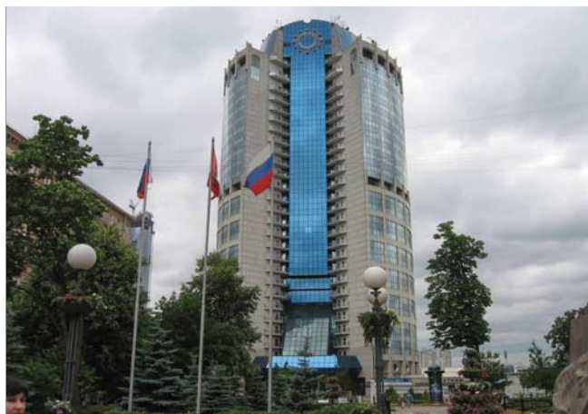
ГУП «МОСВОДОСТОК» Москва, 440 кВт
