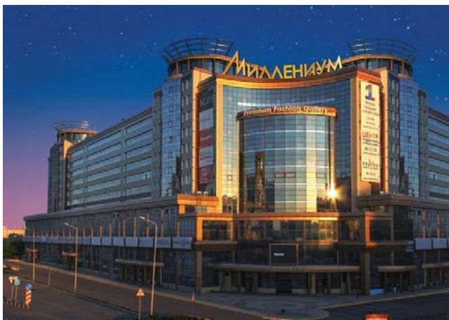
ТОРГОВЫЙ ЦЕНТР «МИЛЛЕНИУМ» Омск, 410 кВт
