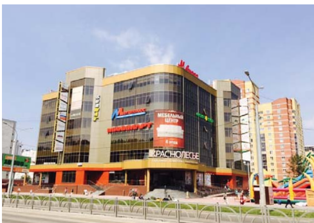
ТОРГОВЫЙ ЦЕНТР «КРАСНОЛЕСЬЕ» Екатеринбург, 700 квТ
