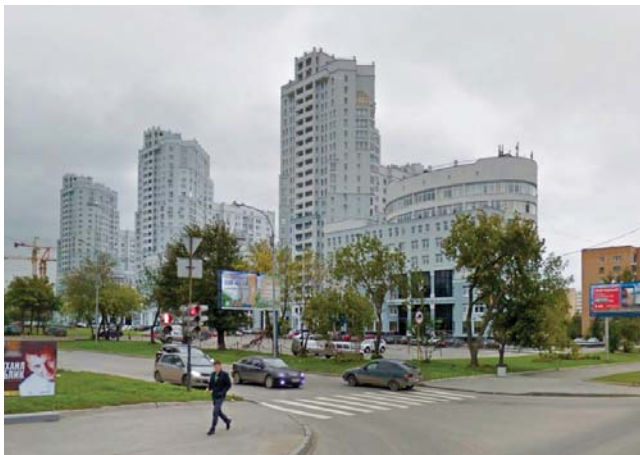
БИЗНЕС-ЦЕНТР «ТАТИЩЕВСКИЙ» Екатеринбург, 500 кВт
