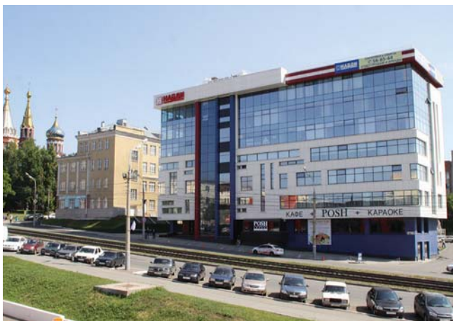
БИЗНЕС-ЦЕНТР «НАЙДИ» Ижевск, 498 кВт
