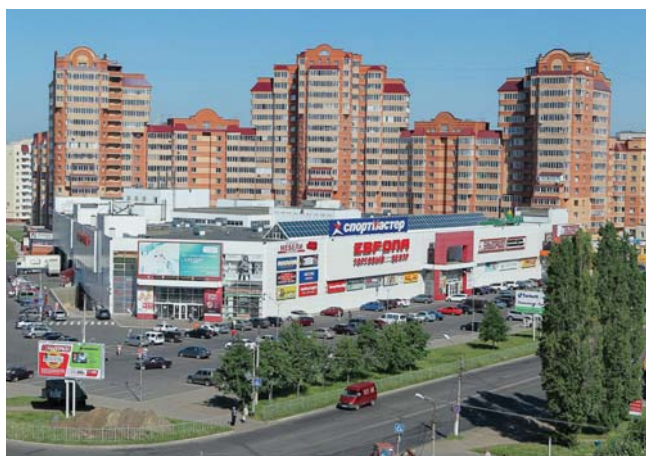
ТОРГОВЫЙ ЦЕНТР «ЕВРОПА 26» Железногорск, 320 квТ
